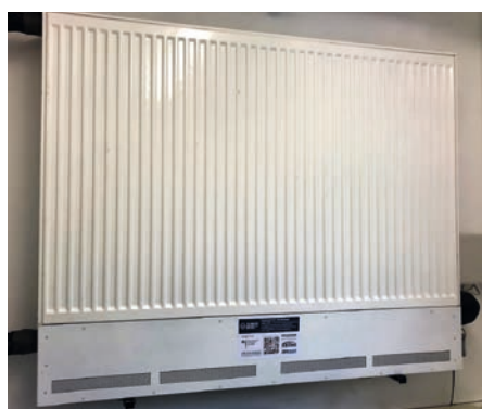
Bild 6: Kühlung eines Serverraumes über „BoostAdapt“.
